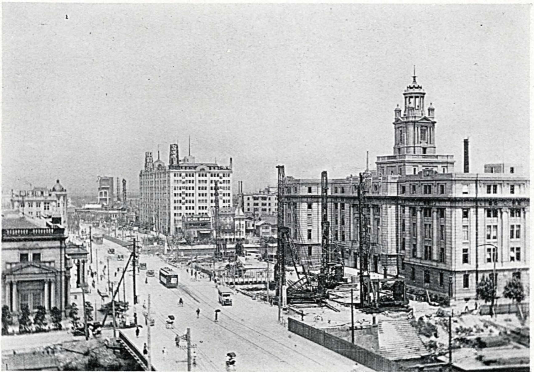
市庁舎前地下鉄道工事全景 (淀屋橋北詰ヨリ北ヲ望見)
